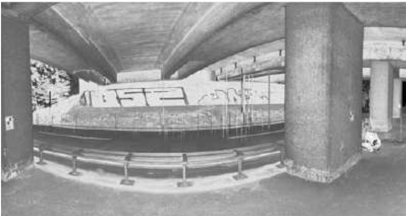
Kuva 1: Esimerkki sillan yhdestä kuvakulmasta (Kuva: Kretschmer U. et al)
