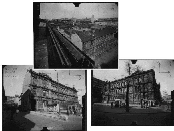
Monikuvamittauksen periaate, yksi kamera, monta kuvaa.
